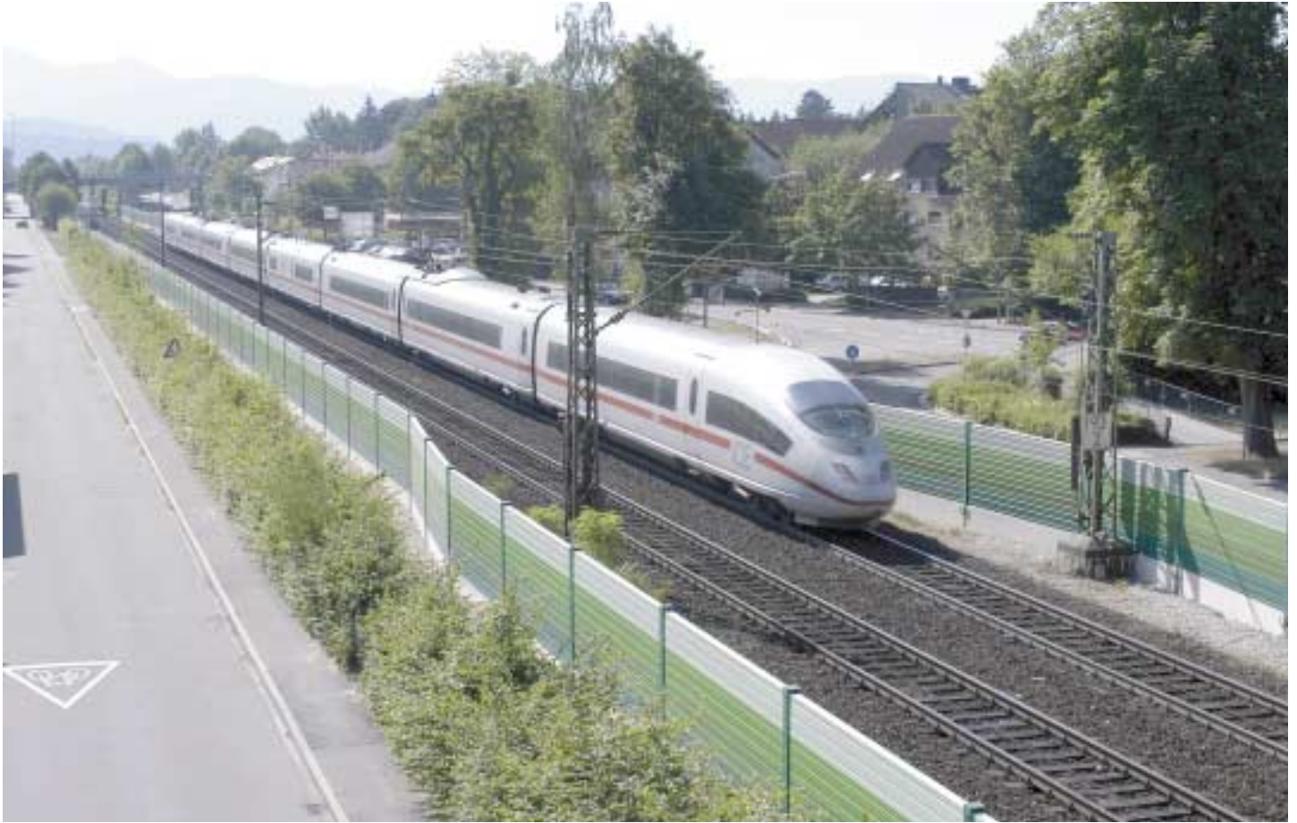
Schallschutzwand in Emmendingen im Rahmen der Lärmsanierung
